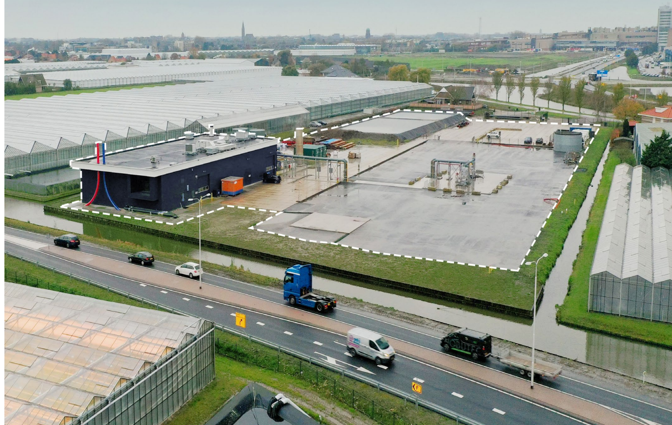
Aardwarmtecentrale Trias Westland.
