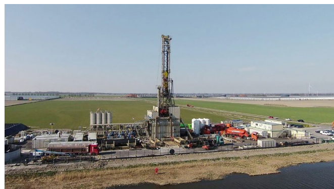
Boren naar geothermie met een boortoren, deze installatie is enkele maanden aanwezig voor aanleg van de aardwarmteputten waarbij enige overlast van geluid/licht kan worden ervaren (de zogenaamde boorfase).
